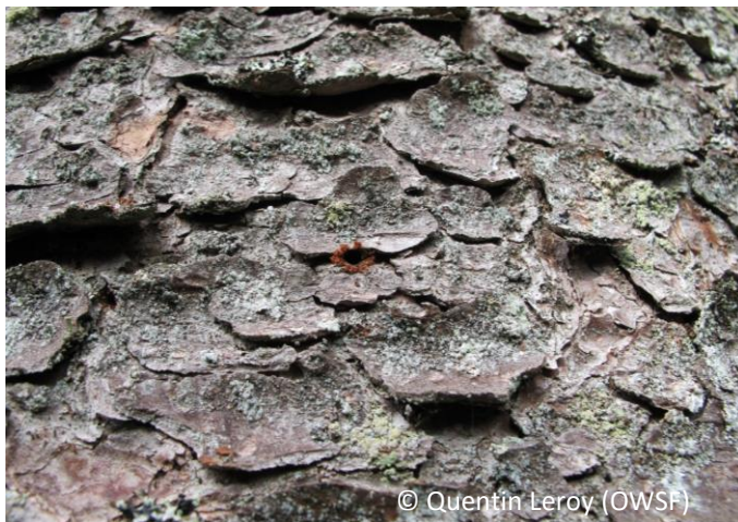
Figure 4: un trou d'entrée avec de la sciure sur épicéa
