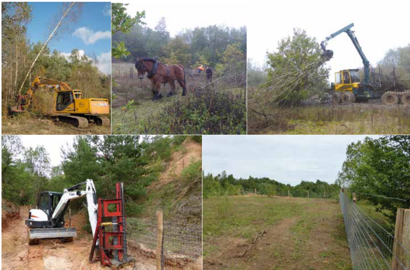
Travaux de restauration: coupe des ligneux et installation des clôtures.
