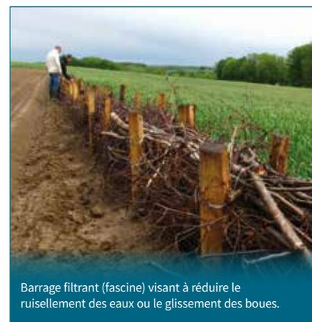
Barrage filtrant (fascine) visant à réduire le ruissellement des eaux ou le glissement des boues.
